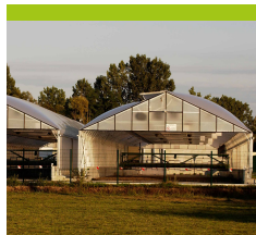
France station de Brumath mise en route : 2004
